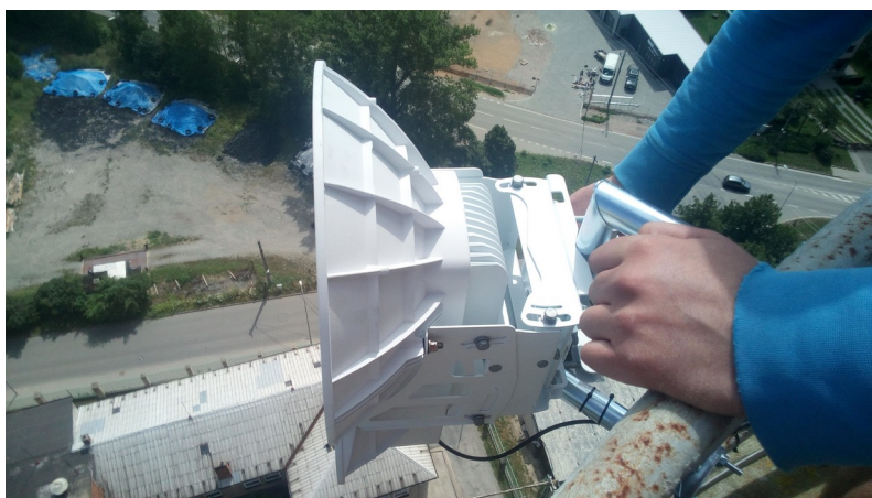
Obrázek 2: Instalace spoje na komíně bývalé papírny Předklášteří
