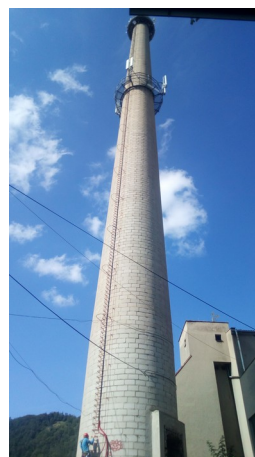
Obrázek 3: Komín bývalé papírny
