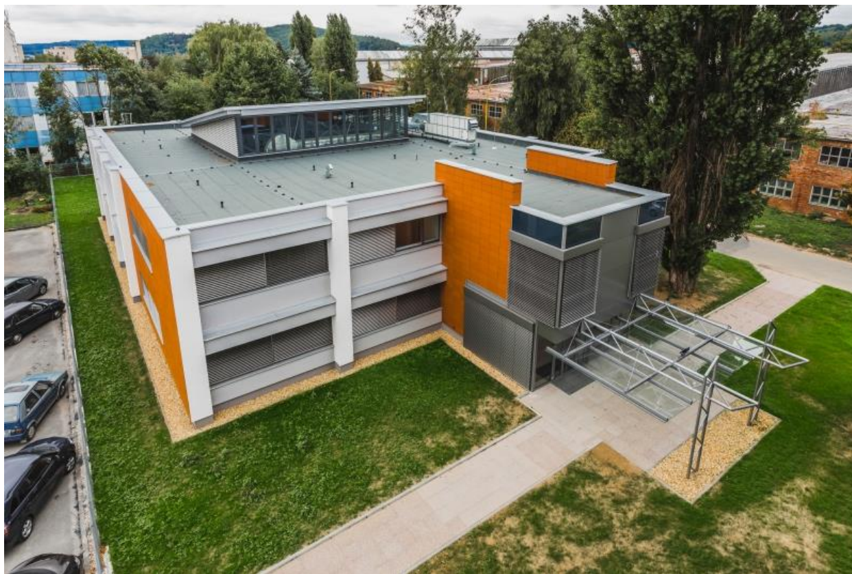
Obr. 1: Budova firmy INTEMAC Solutions s.r.o. v Kuřimi [1].
