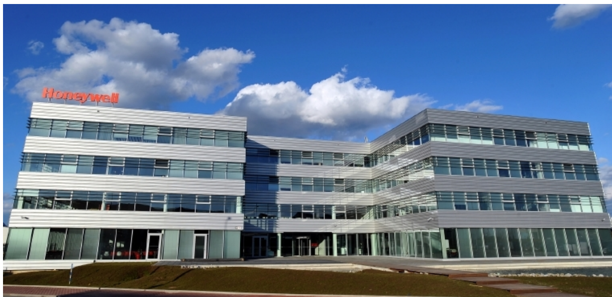
Obr. 2. – Budova C27 pobočky Honeywell v Brně
