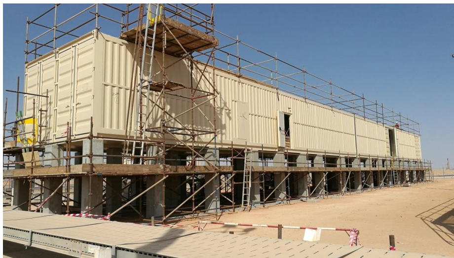
Obr.3 Usazování dvanáctikontejnerové stanice
